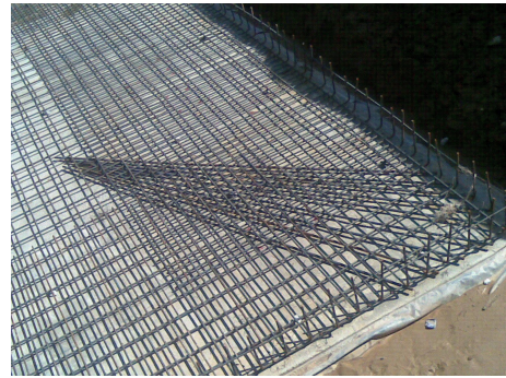
现场增设底板角部放射钢筋
