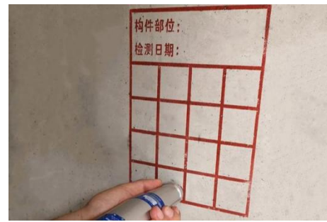
图1 无损检测技术：回弹法
