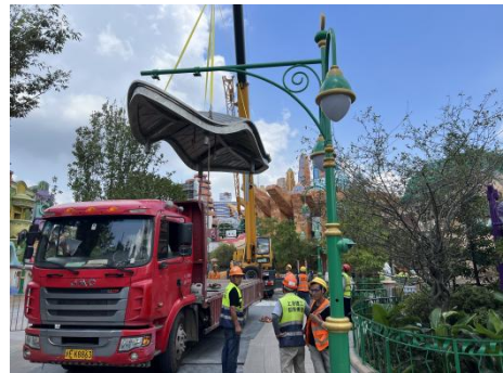
图6 现场整体吊装照片
