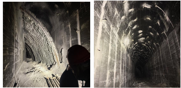
图1 钢护拱加固图片
