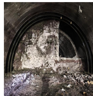
图3 初支钢架施工图片
