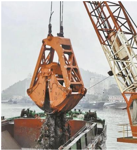
图1 抓斗船和泥驳船配合进行疏浚作业
