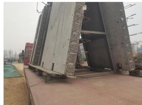
图 1 EMC 预制空心剪力墙示意
