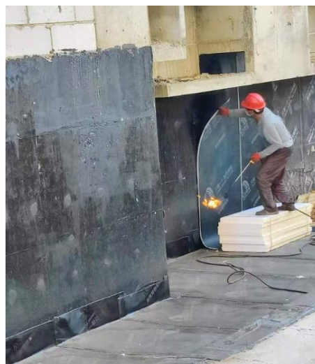
图1 外墙立面防水施工作业过程示意图
