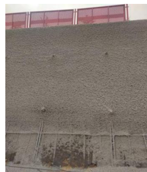
图2 喷射混凝土
