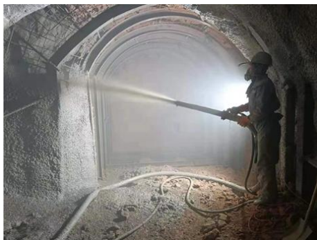
图1 隧道喷射混凝土支护
