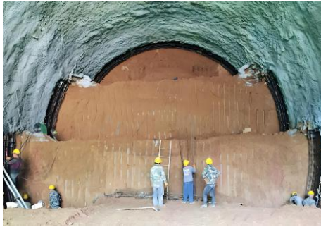
图2 上台阶环形开挖预留
