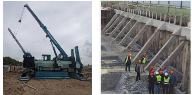
图2 现场施工照片
