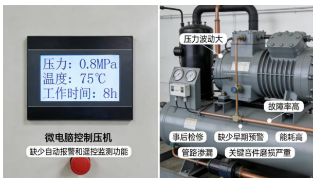
图1：工业螺杆式空压机系统运行现状图
