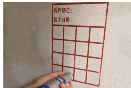
图1 无损检测技术：回弹法
